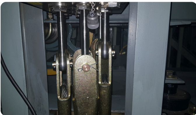
설치 사례 — 로프마다 받는 장력을 맞추기 위해 샤클의 높낮이가 자동으로 달라진 모습
